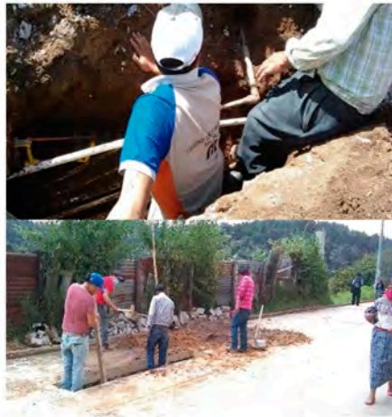
Limpieza, cambio, restauración y mejoramiento de los componentes del sistema de agua potable municipal.
