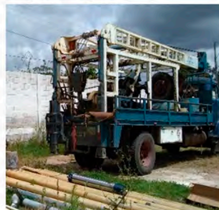
Habilitación del pozo mecánico número 2 del campo de futbol de la zona 3 de esta jurisdicción
