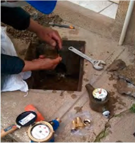
Cambio de accesorios en mal estado y obsoletos en los sistemas de agua potable municipal
